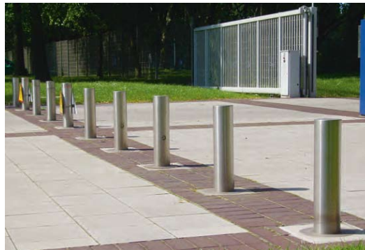
Automatisch versenkbarer Poller mit elektromechanischem Spindeltrieb (Foto: ThyssenKrupp Steel / Bildungszentrum Duisburg)
