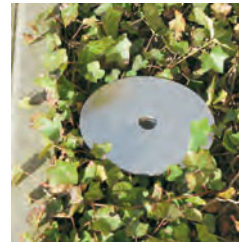
„Parkposition“: demontierbarer Poller kann an anderer Stelle fixiert werden
