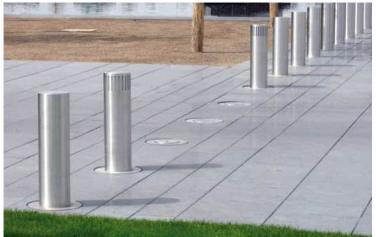
Zufahrt mit drei automatischen Pollern (eingefahren) und rechts und links jeweils ein Signalpoller
