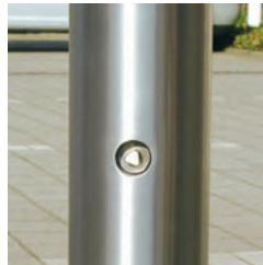
Dreikantschlüssel nach DIN 3223
