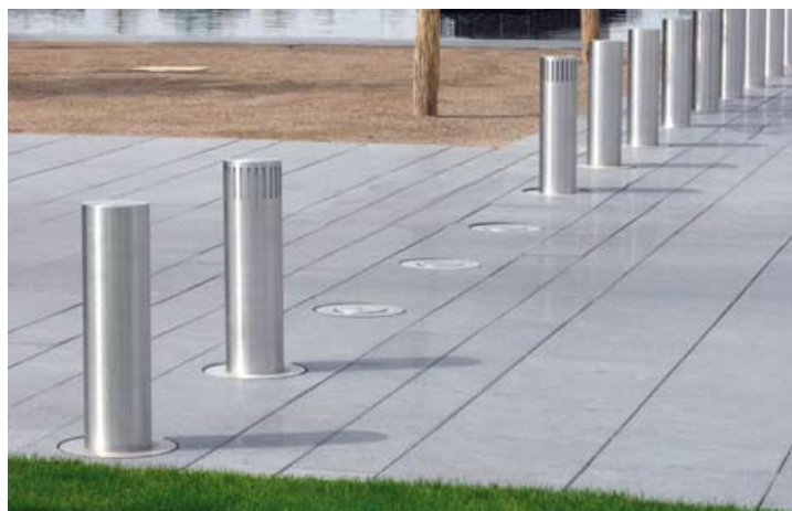
Zufahrt mit drei automatischen Pollern (eingefahren) und rechts und links jeweils ein Signalpoller
